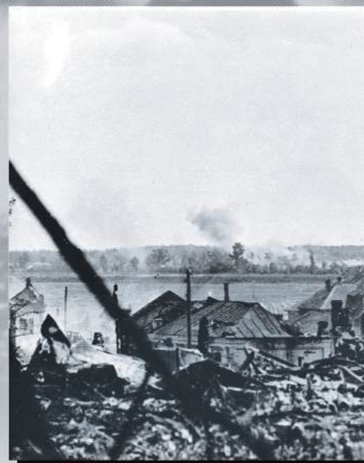
Разрушения г. Жлобина.
