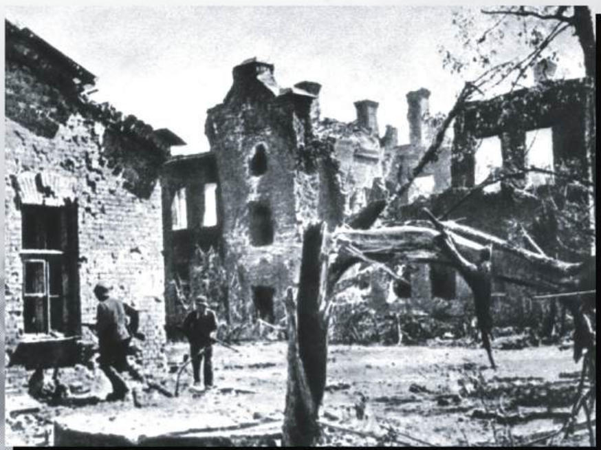
Разрушенный г. Брест.
