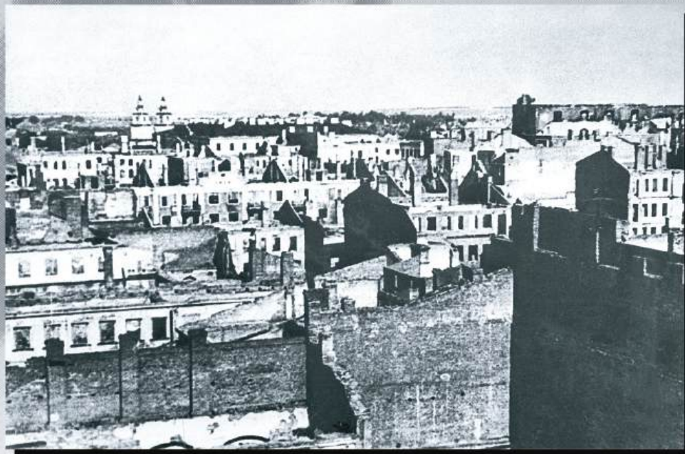
Разрушения в г. Минске.
